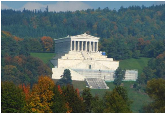
Fig. 3 – Cette photo d'octobre 2013 du Walhalla fut prise en arrivant par la route St2145, une approche par le Sud du Danube qui permet d'apprécier la grandeur du site. [© Auteur]
