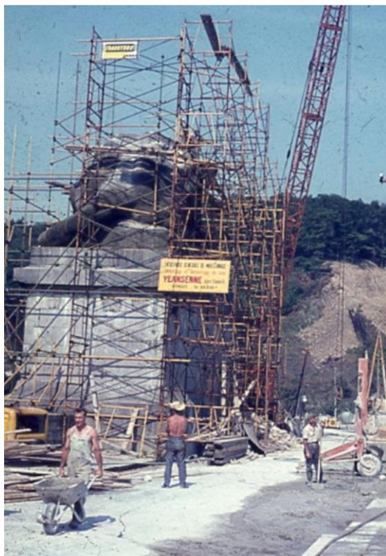
*Préalable à toute modification du mur du barrage, l'altier lion du sculpteur Antoine-Félix Bouré (1831-1883) et son piédestal durent être enlevés. Les 183 blocs de grès constituant l'animal – certains pesant jusqu'à sept tonnes – furent soigneusement séparés en sciant leurs joints et stockés sous abri.*
