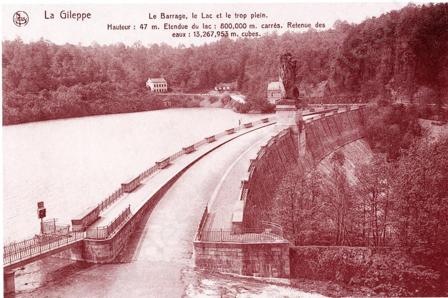
*Sur cette vieille carte postale du barrage de la Gileppe (vu depuis son extrémité Nord-Est), la précision du volume de retenue des eaux fait sourire face à l'arrondi de la superficie. Au déversoir du trop-plein en avant-plan, on notera l'absence de garde-fou vers l'aval vertigineux. La bordure horizontale visible sur le flanc du mur témoigne d'un surhaussement décidé durant l'édification même du barrage, montant celui-ci de 37m à 48m et doublant la capacité de retenue initialement prévue.
