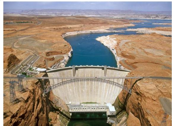
*Dans cette vue aérienne, la "Glen Canyon Dam" arrêtant les eaux de la Colorado River paraît être un petit barrage. Le mur est en fait long de 480m et haut de 220m. Au maximum de sa capacité, le lac Powell ainsi créé peut atteindre 300km de long et 40km de largeur, soit une surface de 65.300ha, et emmagasiner jusqu'à 30km<sup>3</sup> d'eau. La longueur de son rivage est estimée à 3.000km environ.*
