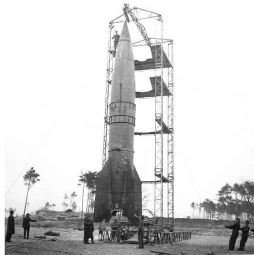
*Préparation d'un essai d'une fusée V2. Sa taille (hauteur de 14m, diamètre de 1,65m, envergure de 3,56m) peut s'apprécier en comparaison de celle des techniciens s'y affairant. [Illustrations ci-dessus court. Bundesarchiv CC BY-SA 3.0]*
